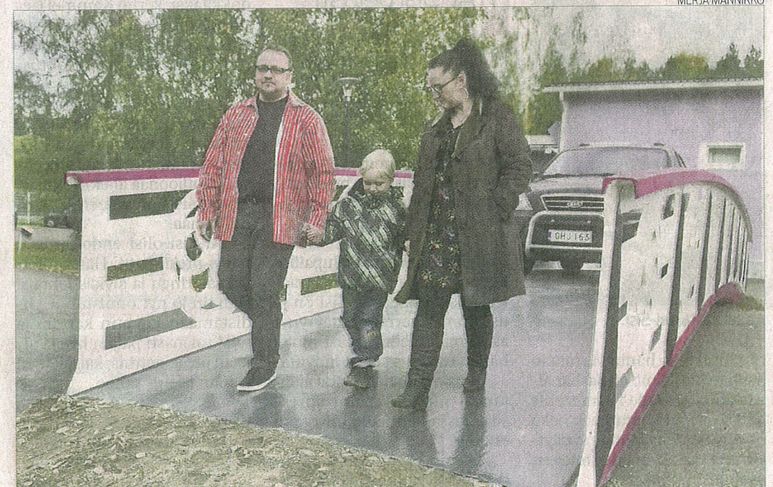
Petri, Werner ja Tatjaana Lappi testaavat uutta lujitemuovista kävelysiltaa, jota autokaan ei hetkauta. Siltaa ei tarvitse huoltaa lainkaan.
